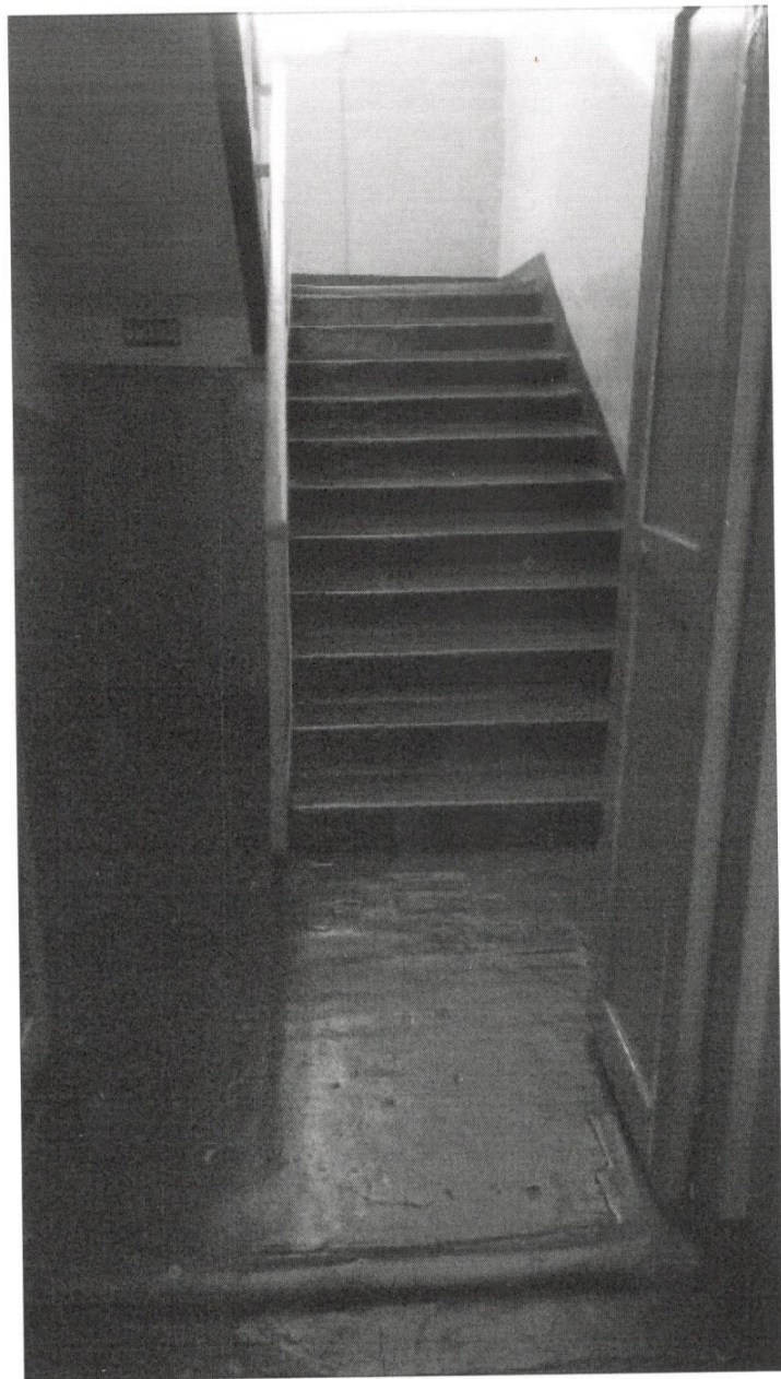
Фото № 12 Лестница внутри здания
