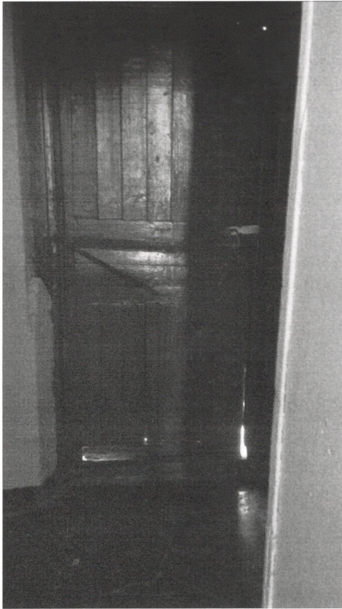
Фото № 10 Эвакуационный выход
