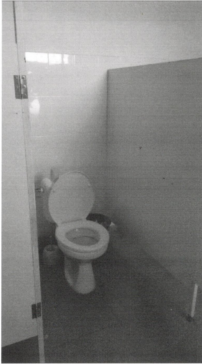
Фото № 14 Санитарно-гигиенические помещения
