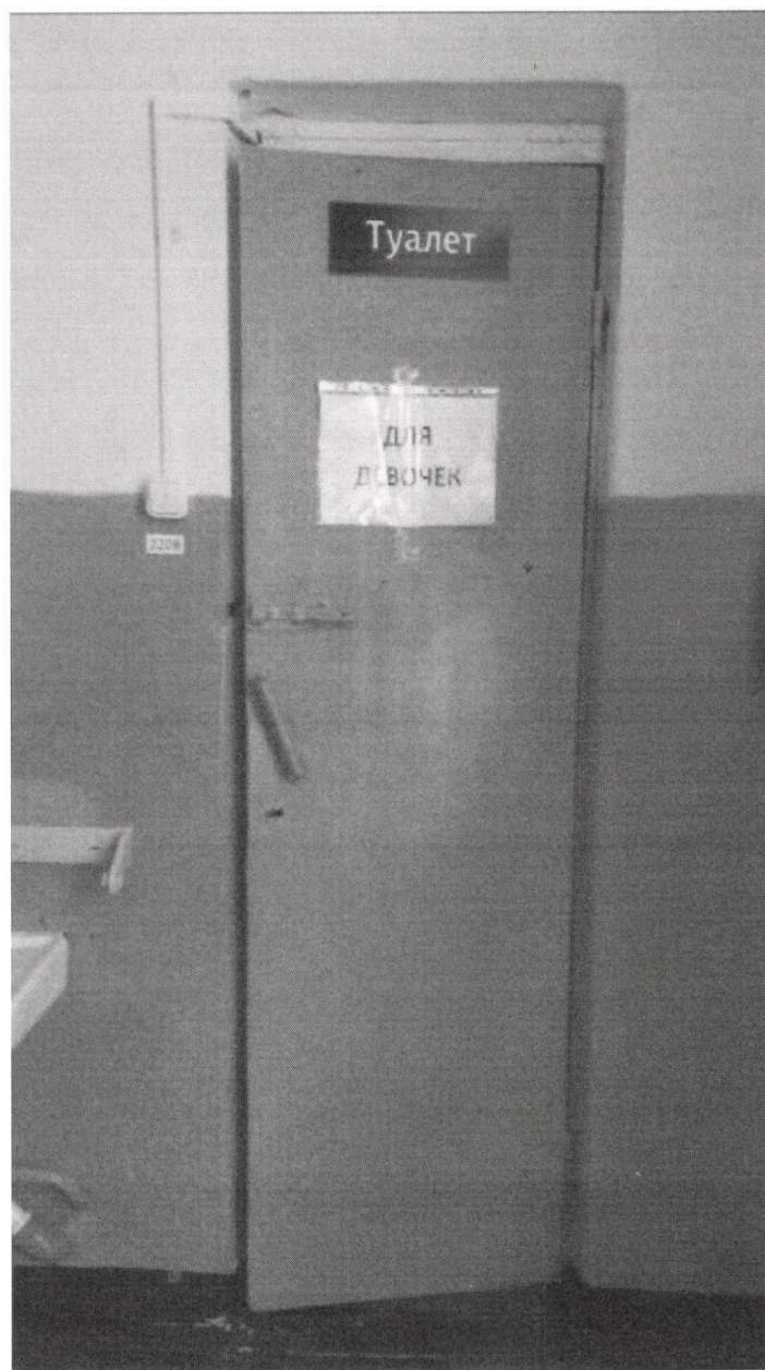
Фото № 13 Санитарно-гигиенические помещения
